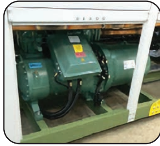
Vidalı Scroll Kompresör Screw Compressor
