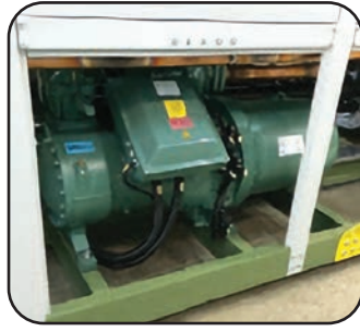
Vidalı Scroll Kompresör Screw Compressor
