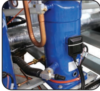
Çoklu Scroll Kompresör Multiple Scroll Compressor
